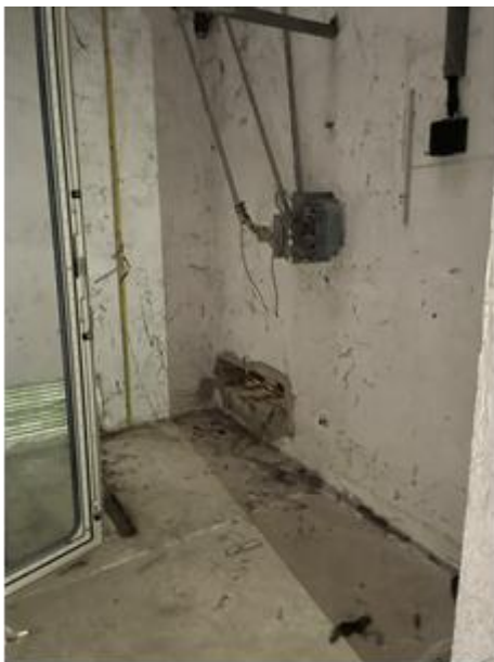
foto 9 – zona cabina elettrica: asportazione trasformatore
